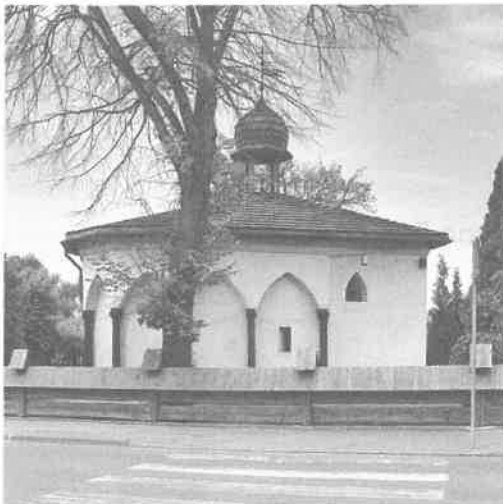
Kaplica widziana od południowego zachodu (2020)
